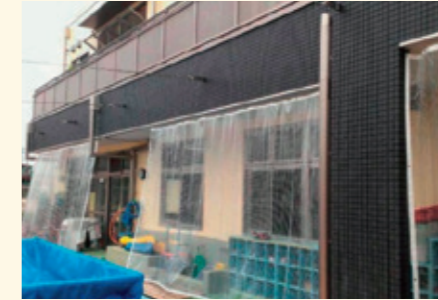
駐輪場 雨・風除け ビニールシート、テントバー使用
