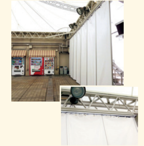
屋上施設 雨風除け 防塵 テントシート、HGレール使用
