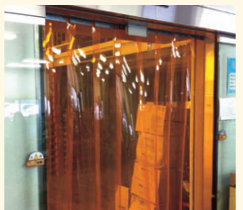
■事務所出入口
