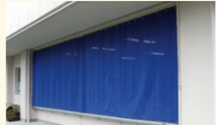
南・西側窓 窓日除け メッシュシート、D40レール使用
