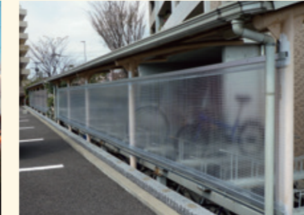
駐輪場 雨・風除け ビニールシート、テントバー使用
