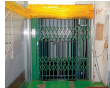
●開口部にビニールシャッター
