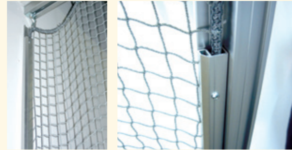
壁にはネットBOXバーで固定 サイドポールにネットBOXバー取付け
