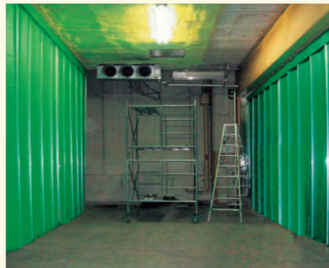
断熱(冷蔵) 断熱シート、D40レール、間仕切ポール使用
