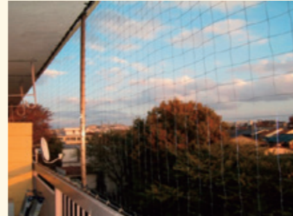
南・西側窓 窓日除け メッシュシート、D40レール使用
