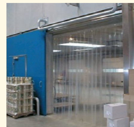
■倉庫内の間仕切 (冷蔵)
