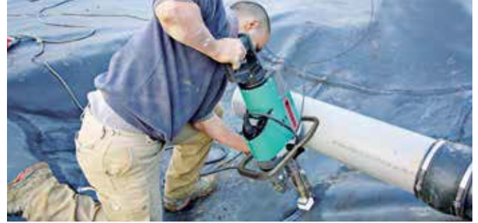
埋立地で肉盛り溶接を行う ウェルドプラストS6
