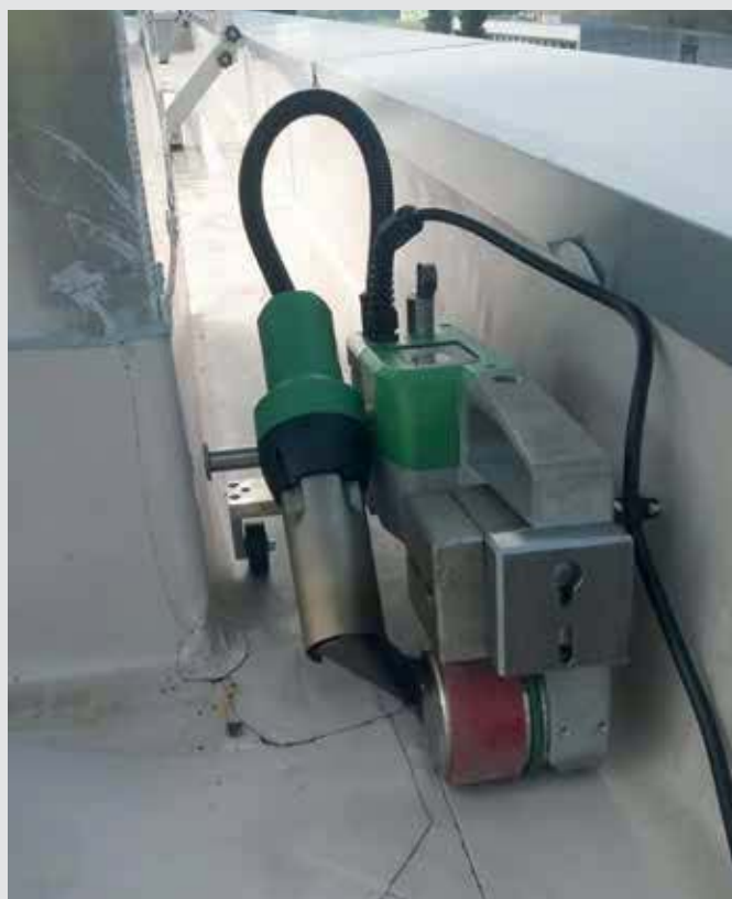
狭いスペースでも楽々自動で溶接。
