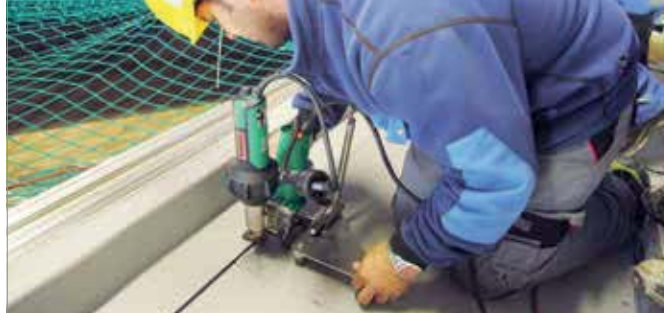
補助ガイドにより、安定性が増え、ツール捌きも安全にできます。
