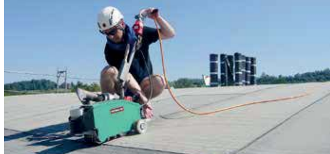
ビトマットB2による改質アスファルトシートの無炎溶着
