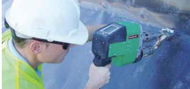
パワフルなウェルドプラストS4を土木遮水シート溶接に使用中
