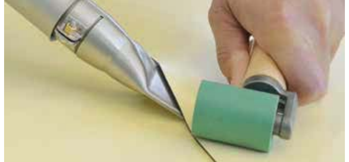
オーバーラップ溶接
