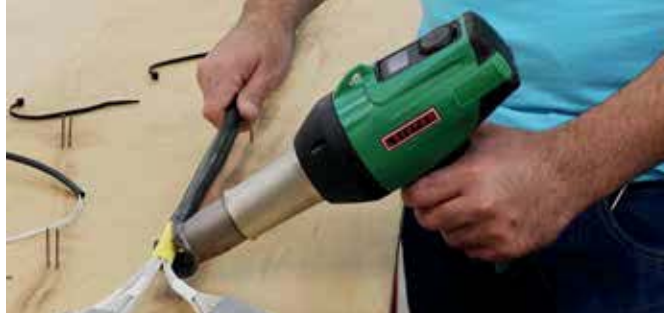
ケーブル終端処理でのシュリンク作業 - ギブリAWは理想的な装置
