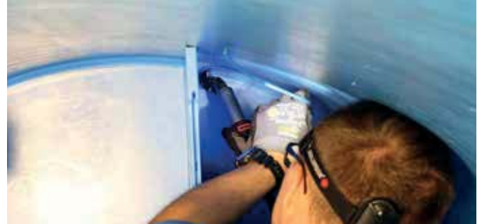
ウェルディングペン Rとアングルアダプターの組み合わせで、狭い場所の溶接が可能
