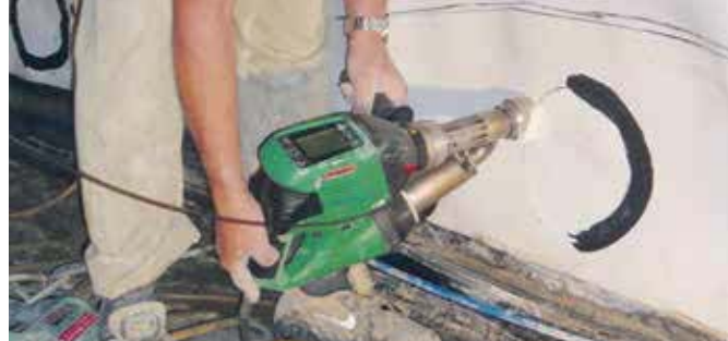
頑丈なウェルドプラストS2で、トンネル遮水シートのパッチ溶接中。
